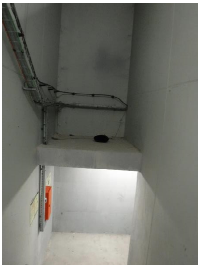
Figure 17 – Chemins de câbles présents dans les issues de secours
