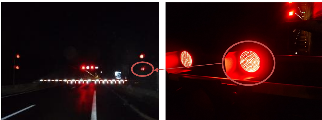
Figure 40 - Dégradation équipements de signalisation dynamique
